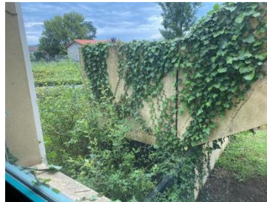
Végétation spontanée sur la toiture et Lierre grimpant sur la façade
