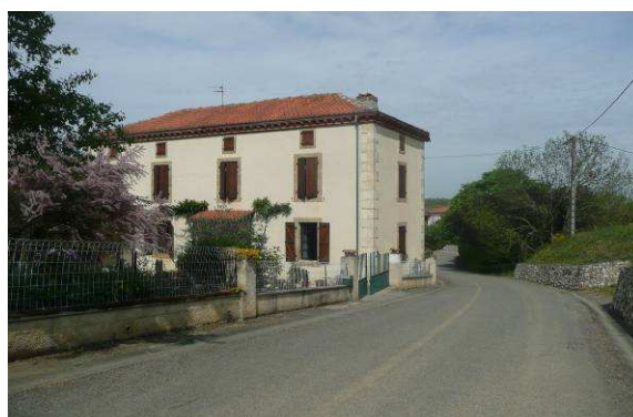
Le mur pignon est aligné sur la rue, la façade principale donne sur une cour et est orientée au sud.
