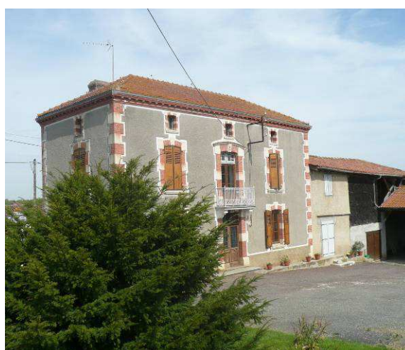
Composition de la façade principale en travée d'ouverture
