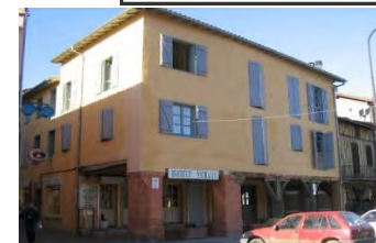
Construite en 2011, la Résidence du Château à l'Isle en Dodon (propriété OPH31)
