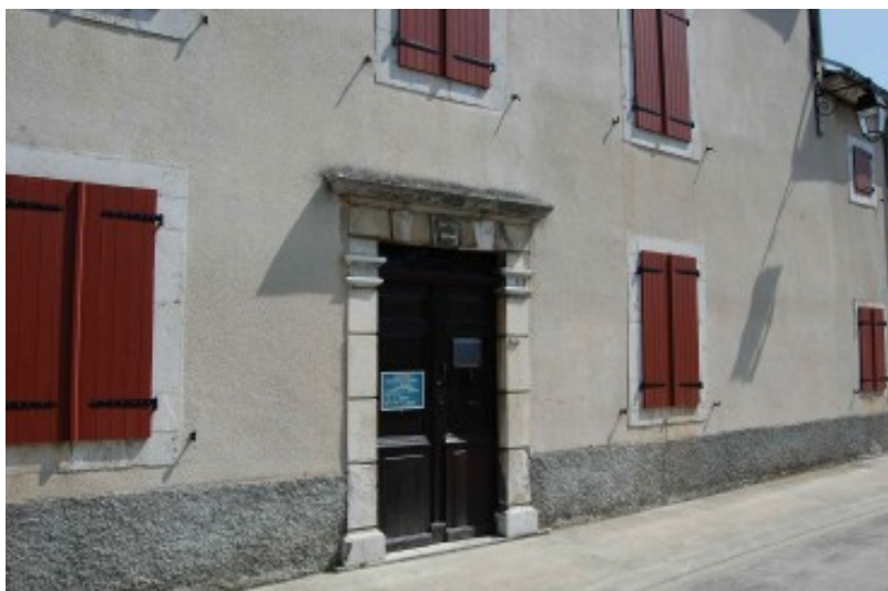
Photo n° 2 : Commune de Miramont-de-Comminges : la mairie. Lors de la crue du 19/06/2013, la mairie a été inondée, il y avait 0.05 à 0.10 m d'eau à l'intérieur du bâtiment.
