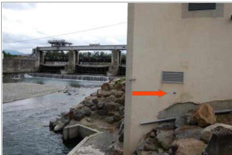
Photo n° 1 : Commune de Clarac, en aval du barrage de Clarac. Il existe un repère de la crue du 19/06/2013 (393.06 m NGF).
