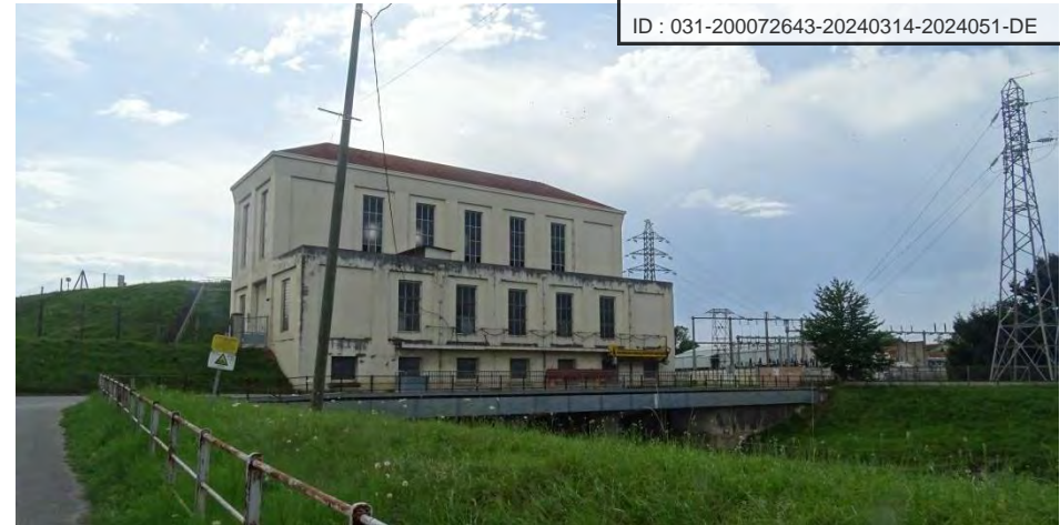
Photo 8 : Centrale hydroélectrique de Valentine – Source : EVEN Conseil
