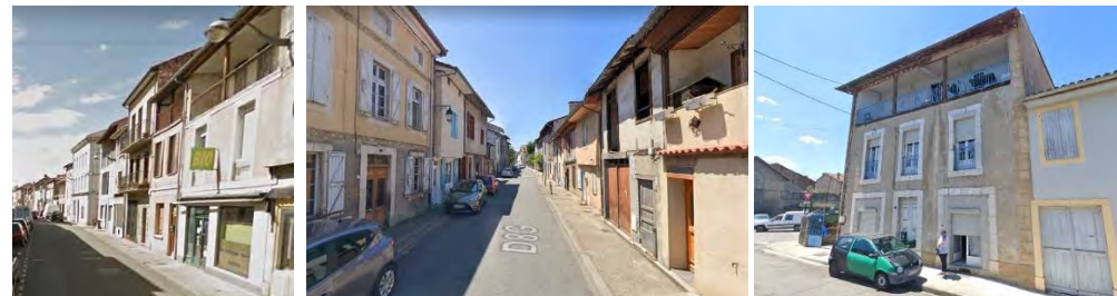
ci-dessus : la rue Du Barry à Montréjeau et à Valentine, une rue du centre bourg et une maison à galerie
