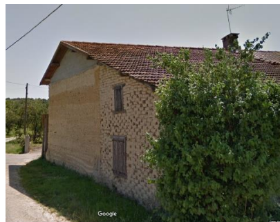
Les matériaux originalement présents dans la construction : ci-dessus, l'usage de la terre crue (mur en pisé et adobe) à Saint Ignan, un mur banché en galets à Liéoux, ci-contre, à Montréjeau un mur en galets et pierres
