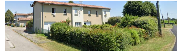
Aménagement de trottoirs sans connexion avec le sécurisée avec le bourg (Pointis-Inard)
