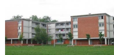
Datant de 1975 la résidence des Pyrénées II à Montréjeau (1979) comprend 14 logements – Propriété OPH 31
