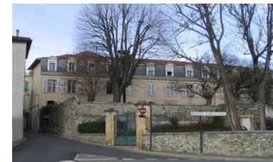
La résidence du Soumès à St Gaudens (2002) comprend 16 logements- Propriété OPH 31
