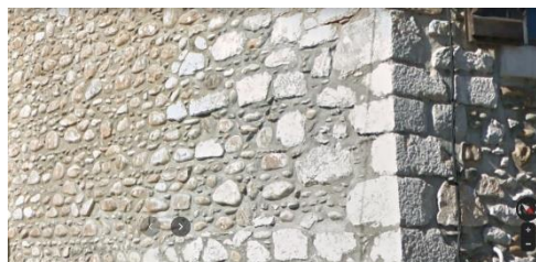
Les matériaux originalement présents dans la construction : ci-dessus, l'usage de la terre crue (mur en pisé et adobe) à Saint Ignan, un mur banché en galets à Liéoux, ci-contre, à Montréjeau un mur en galets et pierres
