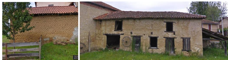
Les matériaux originellement présents dans la construction : ci-dessus, l'usage de la terre crue à Montbernard et à Charlas
