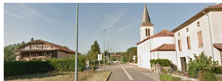
Ex de Nizan-Gesse avec aménagements pour sécuriser les déplacements piétons au niveau de la RD17
