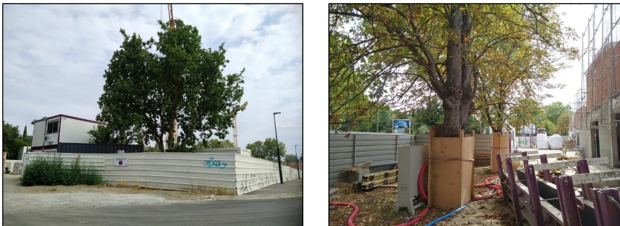
Figure 15.. Chantier délimité par une barrière fixe (à gauche) ; Arbres protégés pendant un chantier (à droite).
