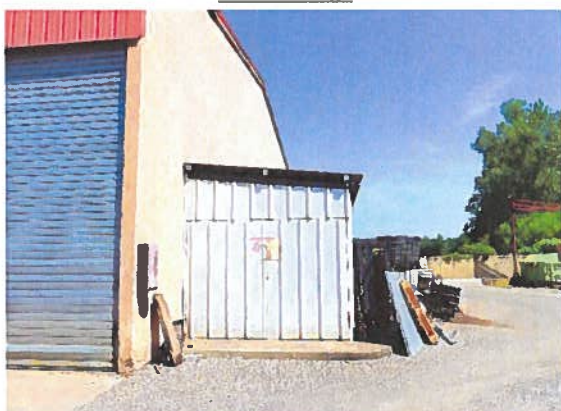
Local chaudière gaz accolée à l'Atelier
