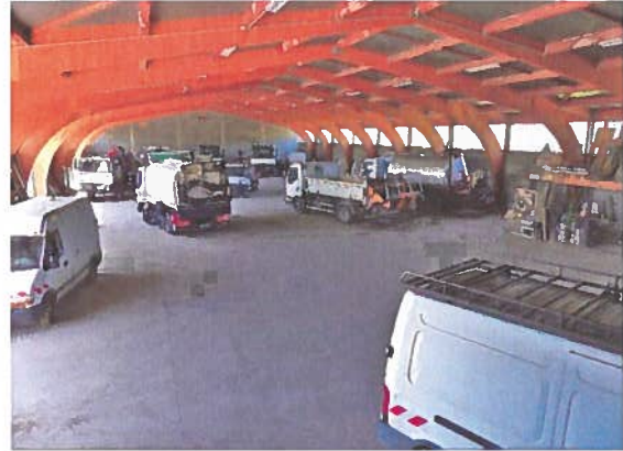
Bâtiment "Garage" du service Voirie
