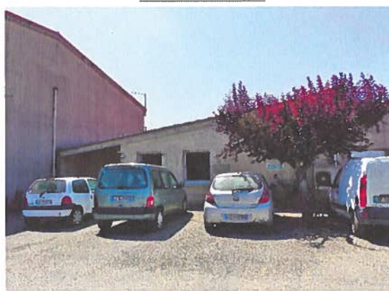
Entrée du site (bâtiment d'accueil/locaux sociaux)
