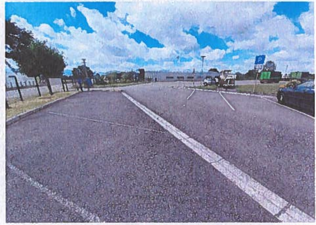
Parking visiteur/voirie côté route du Circuit
