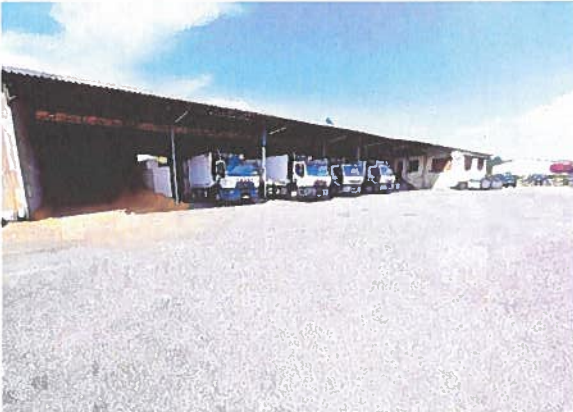
Garage et BOM du Service Ramassage (collecte)
