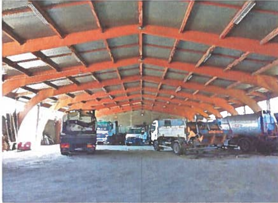
Bâtiment "Garage" du service Voirie
