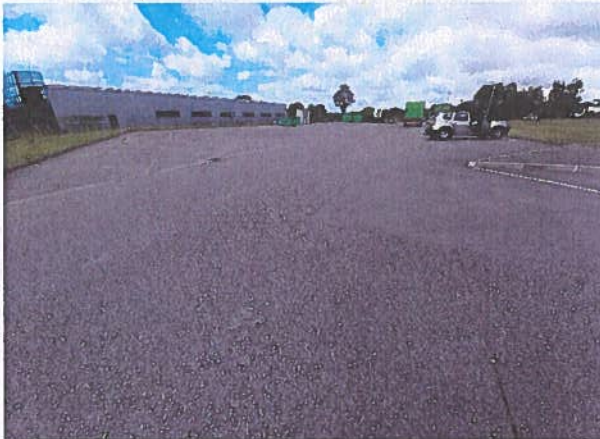
Enrobés/voirie Sud (accès au Centre de Tri)
