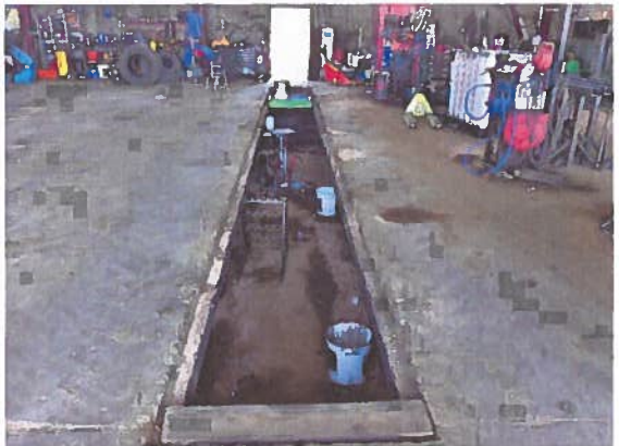
Fosse d'entretien sous le pont roulant PL
