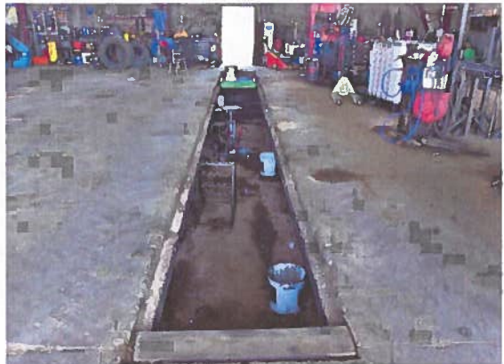
Fosse d'entretien sous le pont roulant PL
