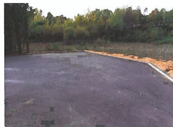
Aire de manœuvre en bas de quais (zone extension)
