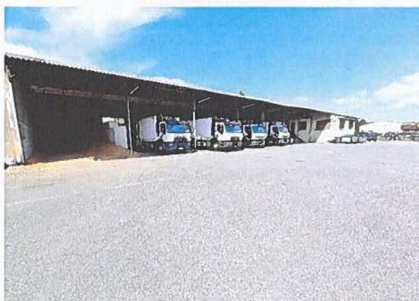
Garage et BOM du Service Ramassage (collecte)
