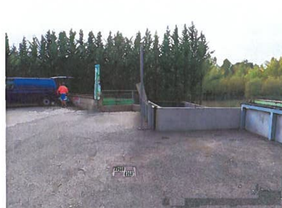
Haut de quai : limite des travaux d'extension
