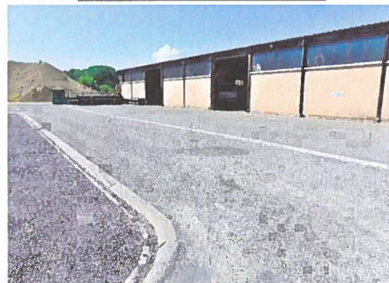
Bâtiment Garage vu depuis l'angle de la cours technique
