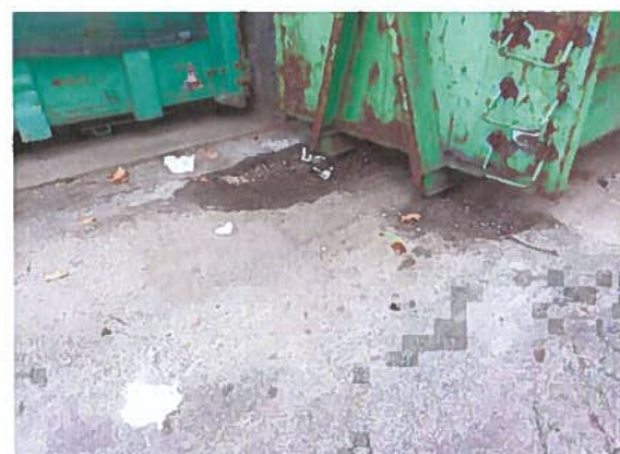
Bas de quai et dalles béton
