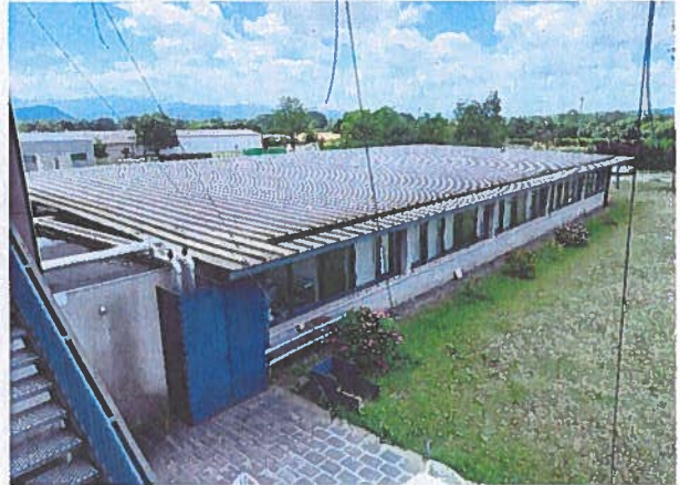
Toiture bac acier du bâtiment administratif
