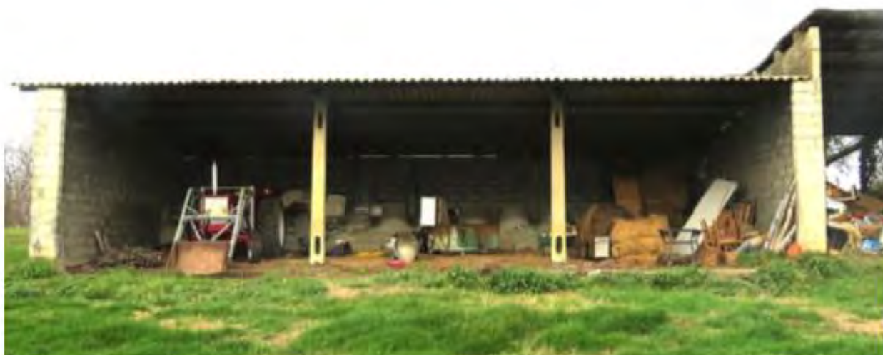
Le pré-haut (ancien bâtiment agricole)
