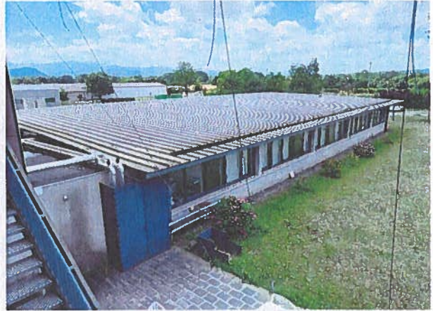
Toiture bac acier du bâtiment administratif
