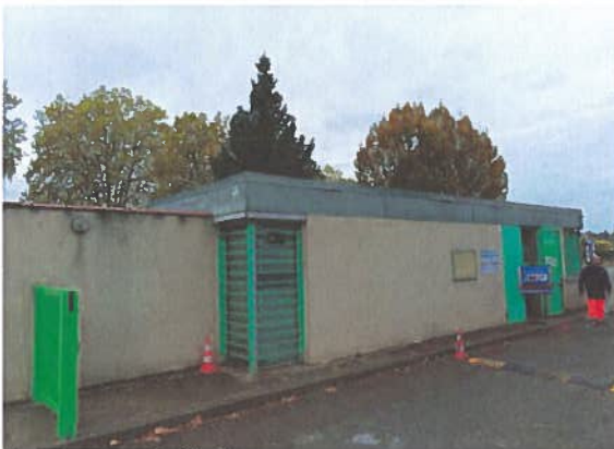
Bâtiment d'accueil et locaux sociaux
