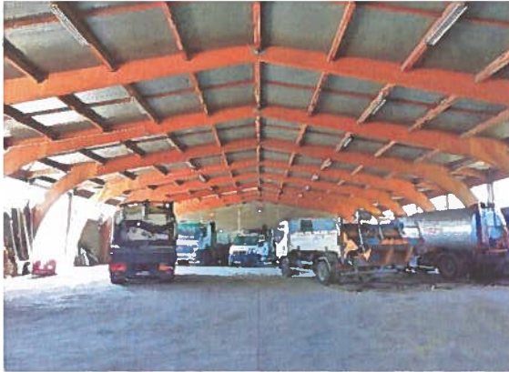
Bâtiment "Garage" du service Voirie
