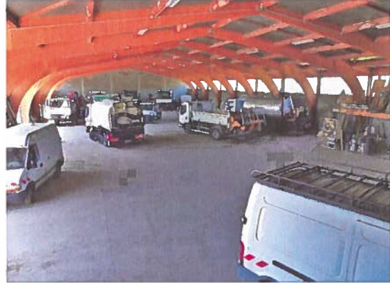
Bâtiment "Garage" du service Voirie
