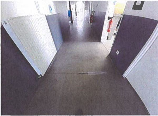
Couloir central desservant les bureaux
