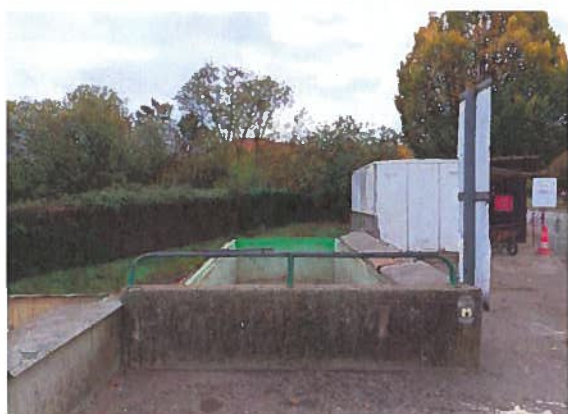
Mur de quai (petit côté)
