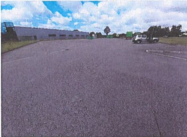
Enrobés/voirie Sud (accès au Centre de Tri)
