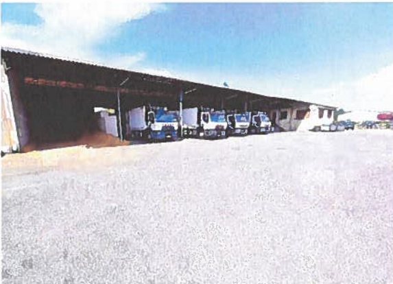
Garage et BOM du Service Ramassage (collecte)
