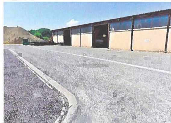
Bâtiment Garage vu depuis l'angle de la cours technique
