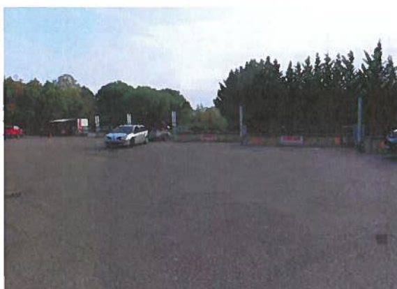
Enrobés haut de quai
