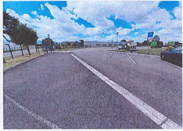
Parking visiteur/voirie côté route du Circuit
