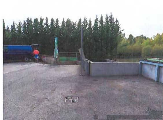
Haut de quai : limite des travaux d'extension
