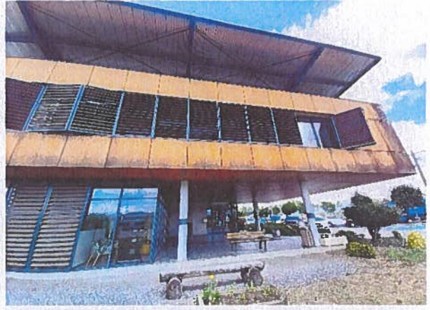
Bâtiment accueil, façade Sud/terrasse couverte
