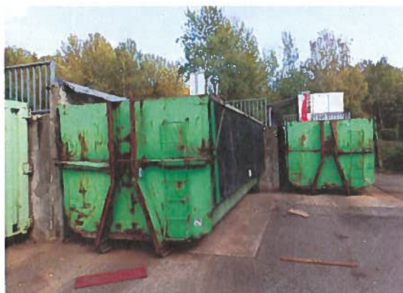
Bas de quai et dalles béton
