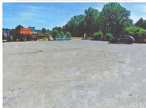
Voirie à l'entrée du site
