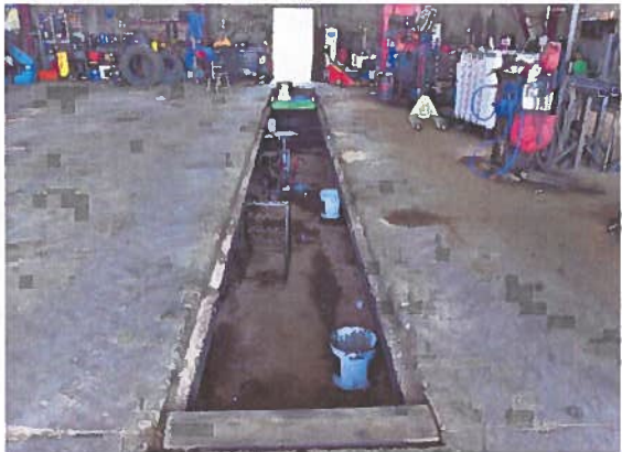
Fosse d'entretien sous le pont roulant PL
