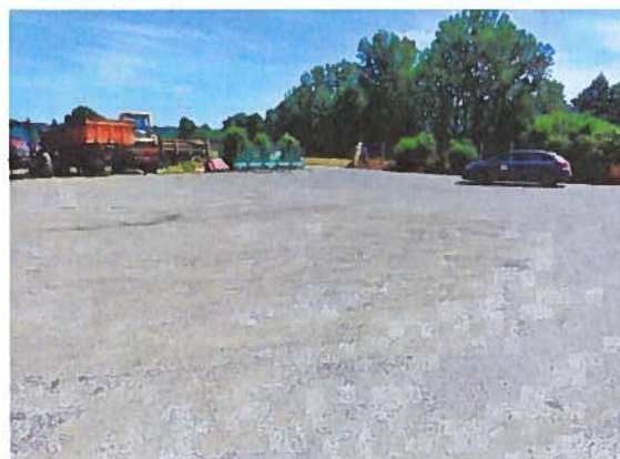
Voirie à l'entrée du site
