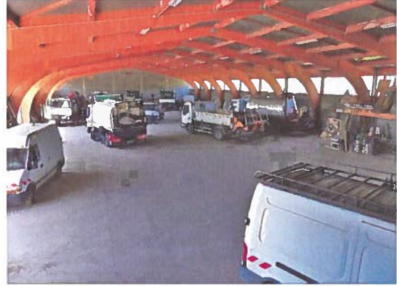
Bâtiment "Garage" du service Voirie
