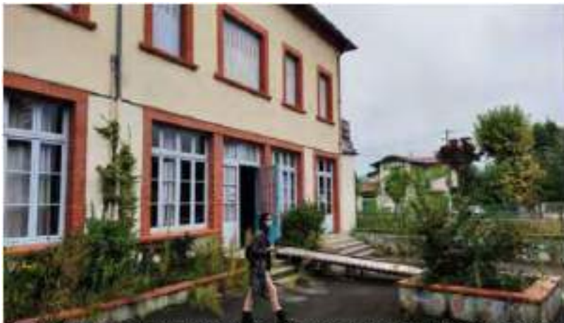
Plusieurs accès aux bâtiments depuis la rue Marcadier et depuis la cour, un niveau de plancher en RDC à 55 cm environ du sol de la cour, des rampes seront à prévoir.
