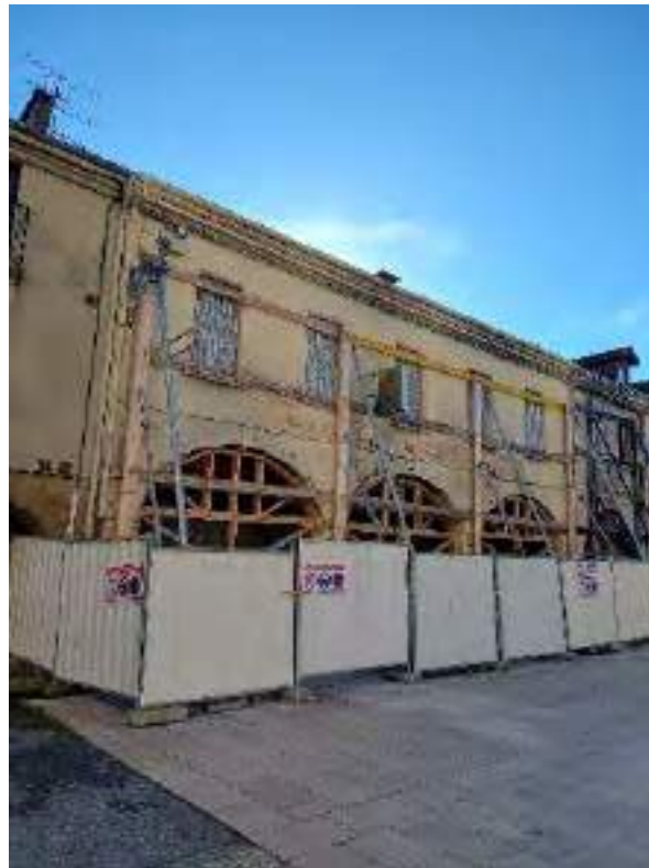
Boulogne-sur-Gesse après l'incendie
