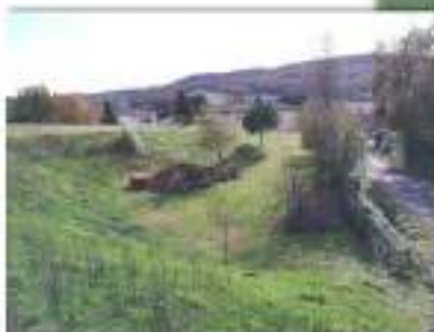
2 – Talus le long du chemin ouest
