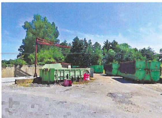
Aire de lavage
