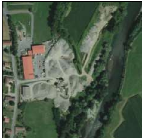
Fig. 31. Les Dragages de Clarac (source Géoportail)
