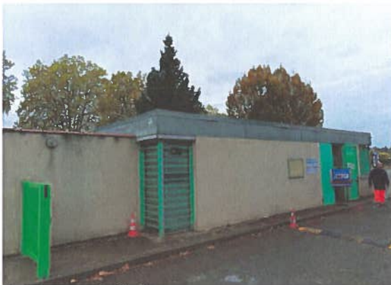
Bâtiment d'accueil et locaux sociaux
