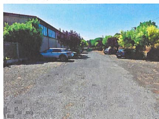
Voirie et parking VL à l'arrière du Garage
