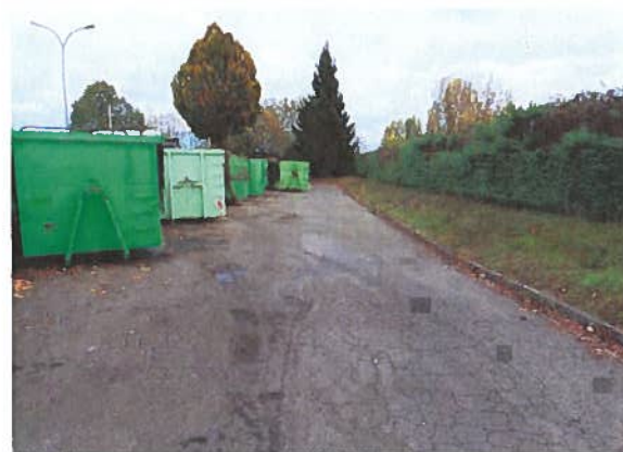
Enrobés bas de quais
