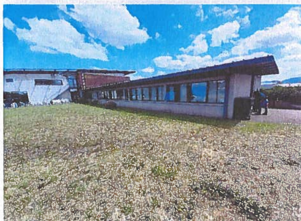
Bâtiment administratif, façade Nord
