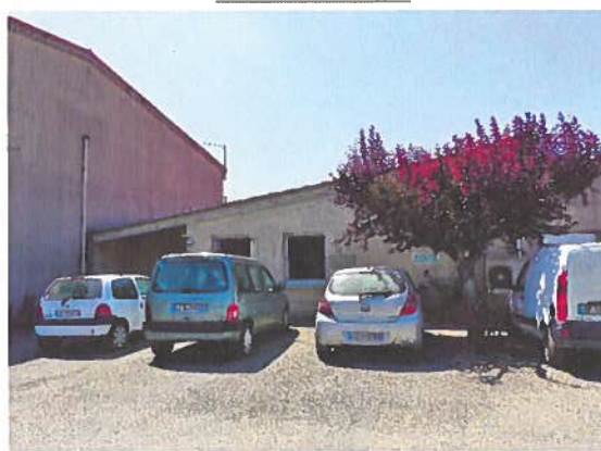
Entrée du site (bâtiment d'accueil/locaux sociaux)
