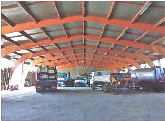
Bâtiment "Garage" du service Voirie
