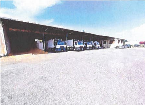
Garage et BOM du Service Ramassage (collecte)
