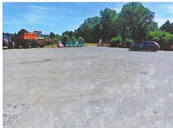
Voirie à l'entrée du site
