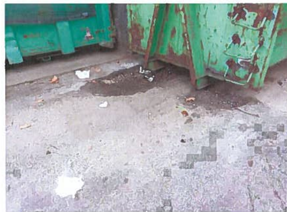
Bas de quai et dalles béton
