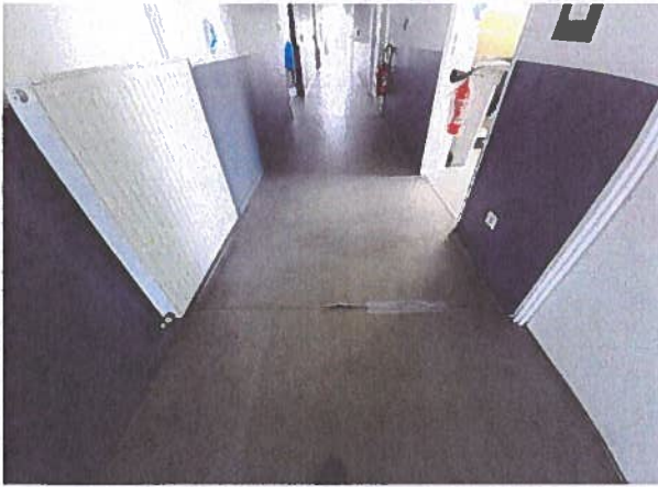
Couloir central desservant les bureaux
