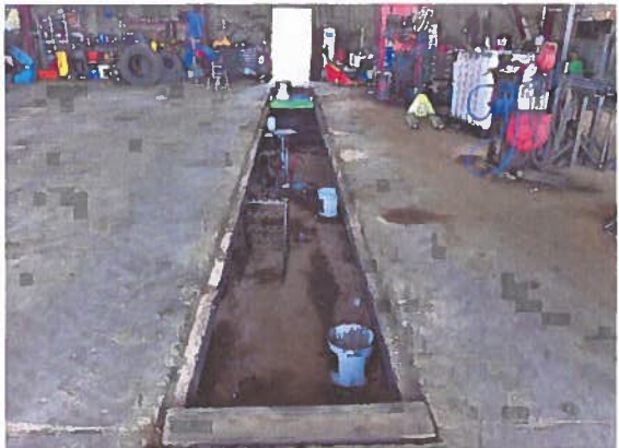
Fosse d'entretien sous le pont roulant PL
