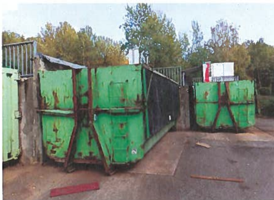
Bas de quai et dalles béton
