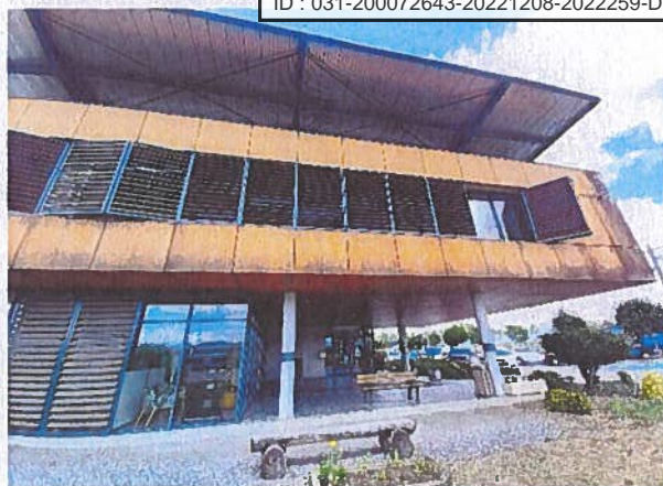
Bâtiment accueil, façade Sud/terrasse couverte
