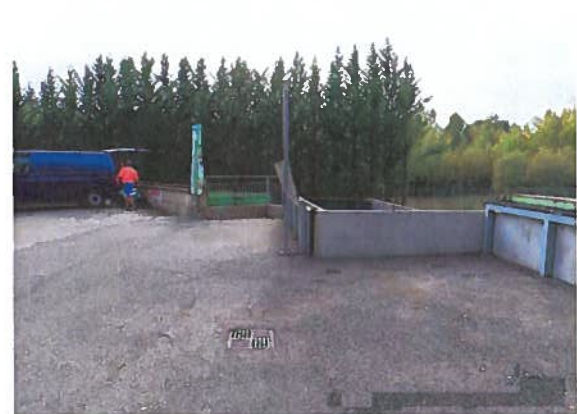
Haut de quai : limite des travaux d'extension
