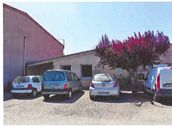
Entrée du site (bâtiment d'accueil/locaux sociaux)
