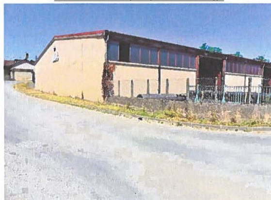
Bâtiment Garage vu depuis accès côté cours technique
