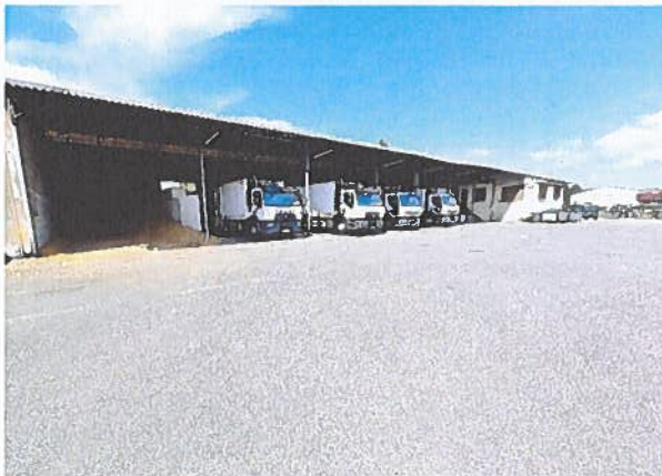
Garage et BOM du Service Ramassage (collecte)
