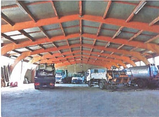
Bâtiment "Garage" du service Voirie
