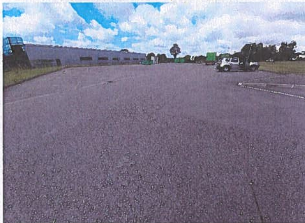
Enrobés/voirie Sud (accès au Centre de Tri)
