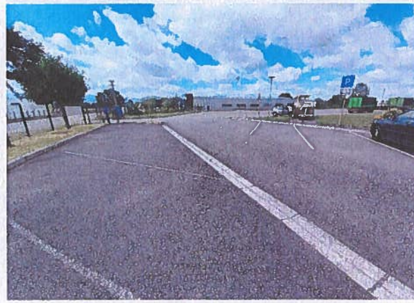
Parking visiteur/voirie côté route du Circuit
