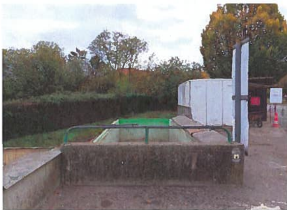
Mur de quai (petit côté)
