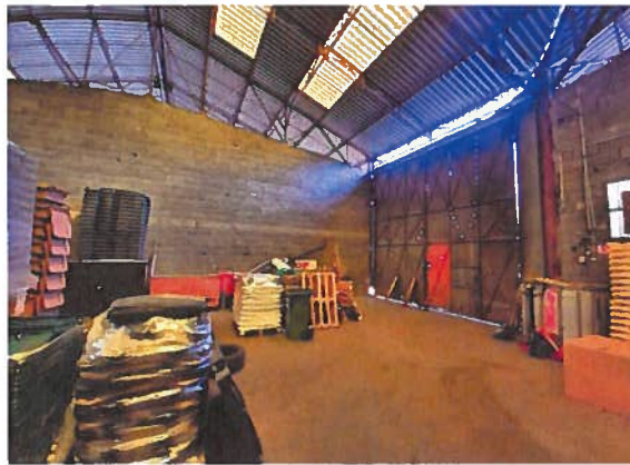
Partie fermée du garage Collecte
