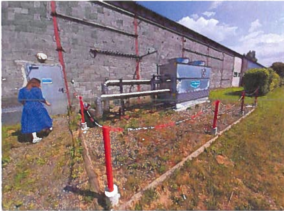
Arrière du bâtiment et accès au local chaudière Bois
