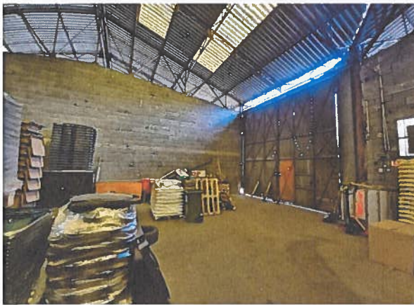
Partie fermée du garage Collecte
