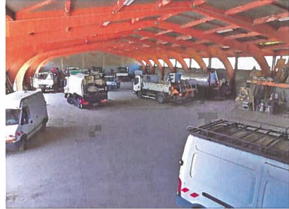
Bâtiment "Garage" du service Voirie
