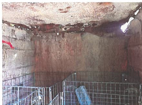
Intérieur container DEEE
