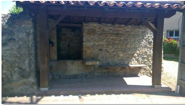
Réhabilitation d'un puits dans le cœur du bourg lors de l'aménagement des espaces publics.
