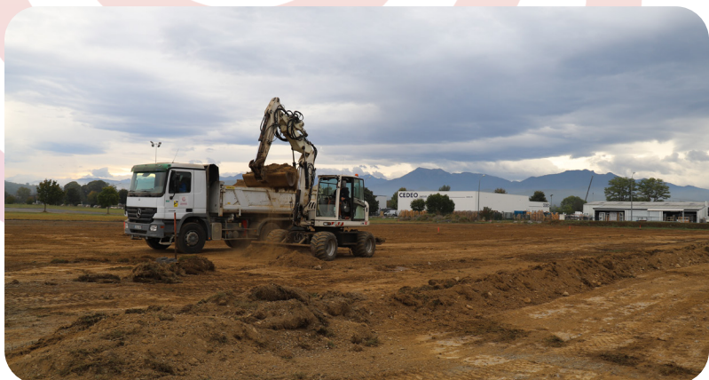
Travaux de terrassement du futur bâtiment La halle des Pyrénées
